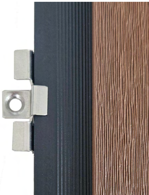
Klipsas lamelinių lentų sujungimo vietoje
