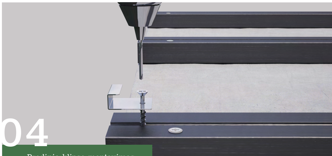
Pradinio klipso montavimas
